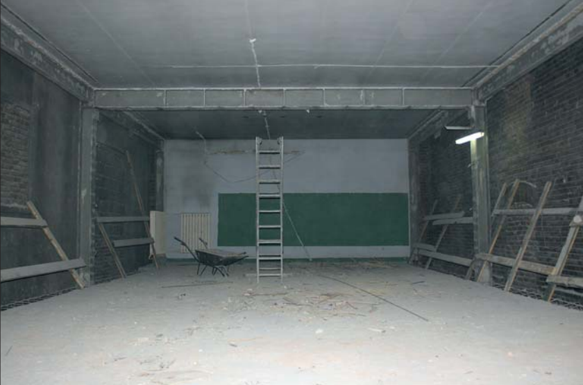
Stara Scena w Galerii została gruntownie przebudowana. Jej kubatura powiększyła się prawie dwukrotnie, w związku ze znacznym podniesieniem stropu, co było konieczne, aby uzyskać odpowiedni kształt pomieszczenia.
