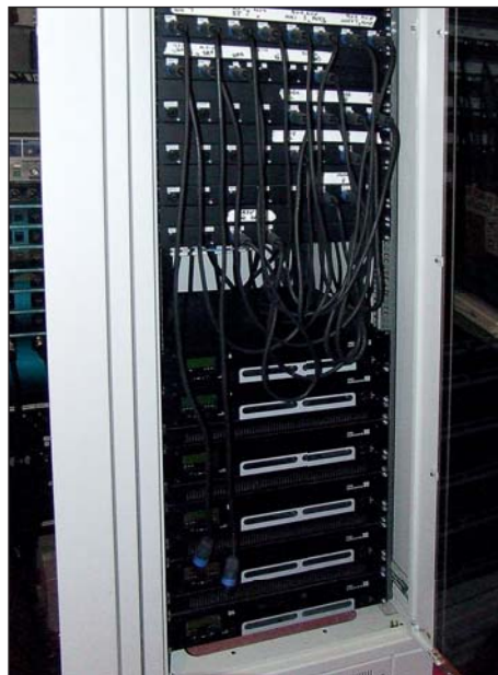
Dwie szafy w kabinie akustyka zawierają interfejs RME, odtwarzacze, 24-kanalowy splitter i krosownicę powrotów oraz krosownicę sygnałów głośnikowych i wzmacniacze mocy d&b audiotechnik D6.
