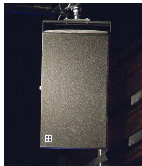
System nagłośnieniowy oparty jest na zestawach głośnikowych znanej niemieckiej firmy d&b audiotechnik – czterech Ci60 i ośmiu Ci80, podwieszanych niemalże w dowolnym miejscu, oraz dwóch subbasach Ci-SUB, znajdujących się pod widownią.
