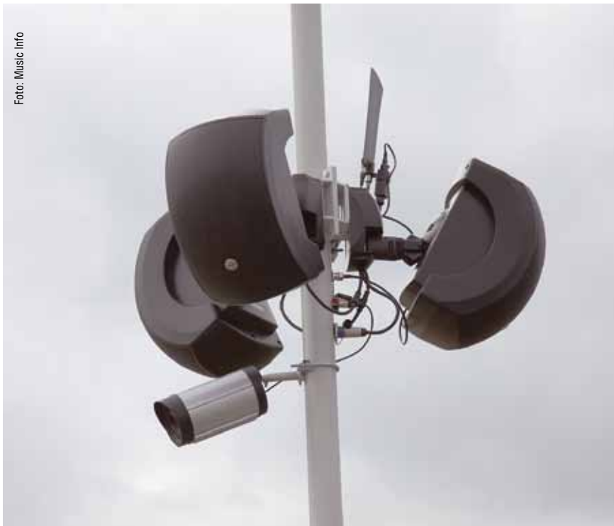
System dogłośnienia placu przed fontanną bazuje na zestawach SMS 4124 firmy EAW, które trójkami przychepione zostały do latarni.
